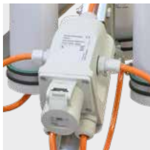
Prise supplémentaire pour créer une chaîne d'éclairage ou alimentation machine outil par exemple
